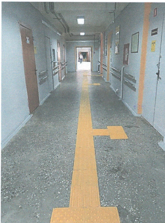
Фото 11. Пути движения в здании оборудованы напольной визуально-тактильной полосой и поручнями, см. фото 11-13.
