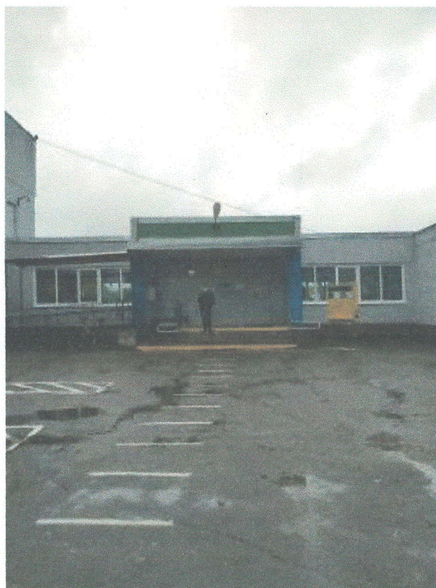
Фото 1. Центральный вход в здание, крыльцо.
