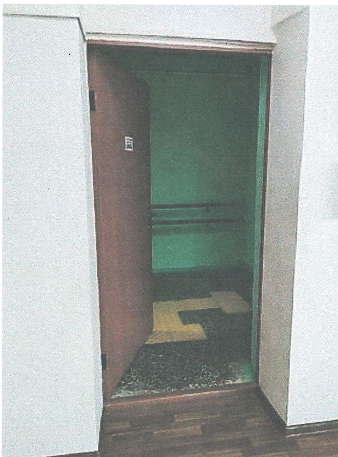
Фото 14. Расширенные проемы в аудиториях.
