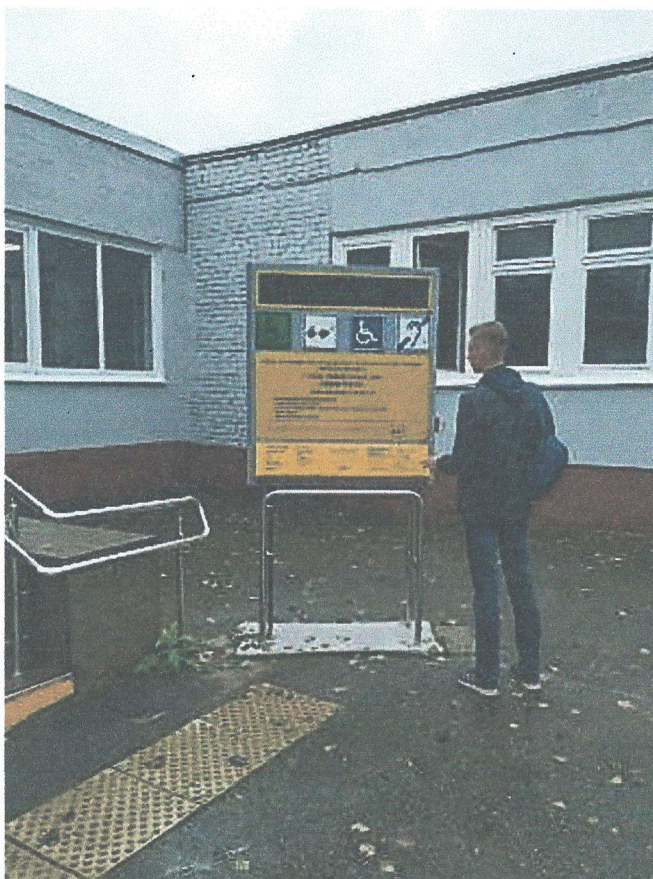
Фото 6. Тактильный информационный стенд для незрячих или слабовидящих людей у центрального входа в здание.
